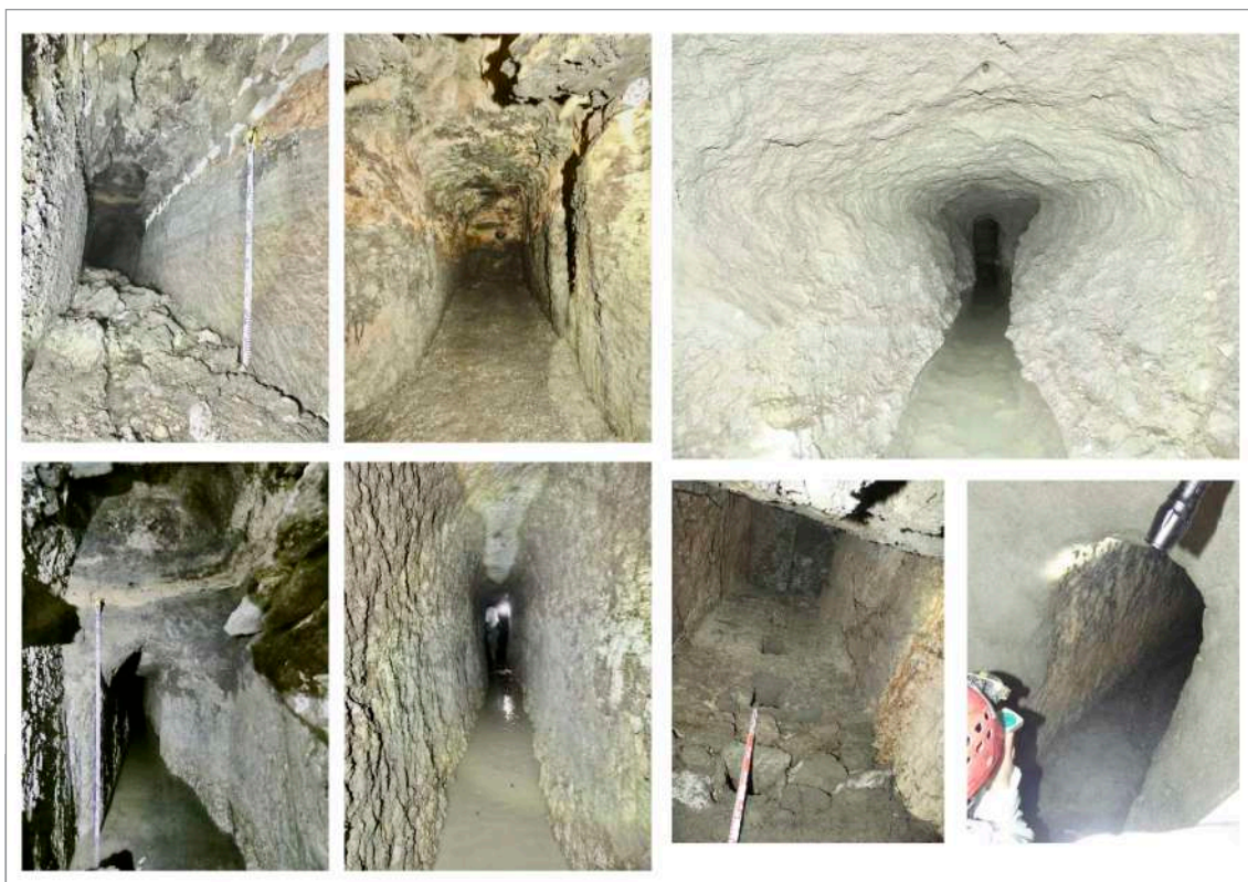
Figura 7.- Diversos aspectos de la mina de calle Palomero.
