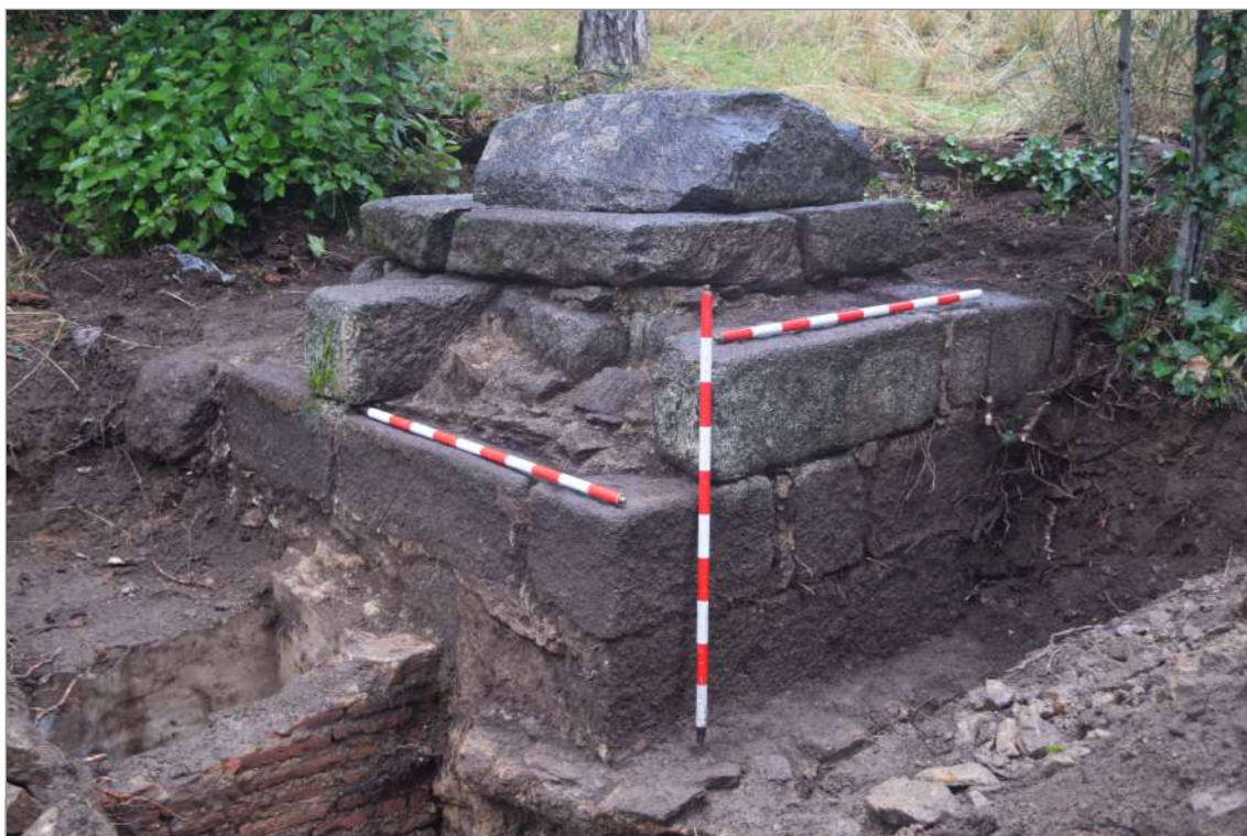
Figura 3. Vista del arca de Carlos Ruíz, 4, desde el sur, durante el sondeo practicado en 2018. A la derecha se aprecian el vaso, realizado en ladrillo, de la fuente pública incorporada en los años 20 del siglo XX.
