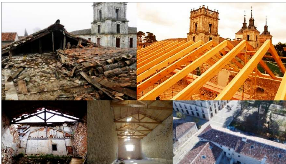
Figura 3: Desarrollo de la consolidación: arriba, la cubierta de las casas y, abajo, de la nave (Foto F. Vallespín y Foto Dron: Rafael Campos).
