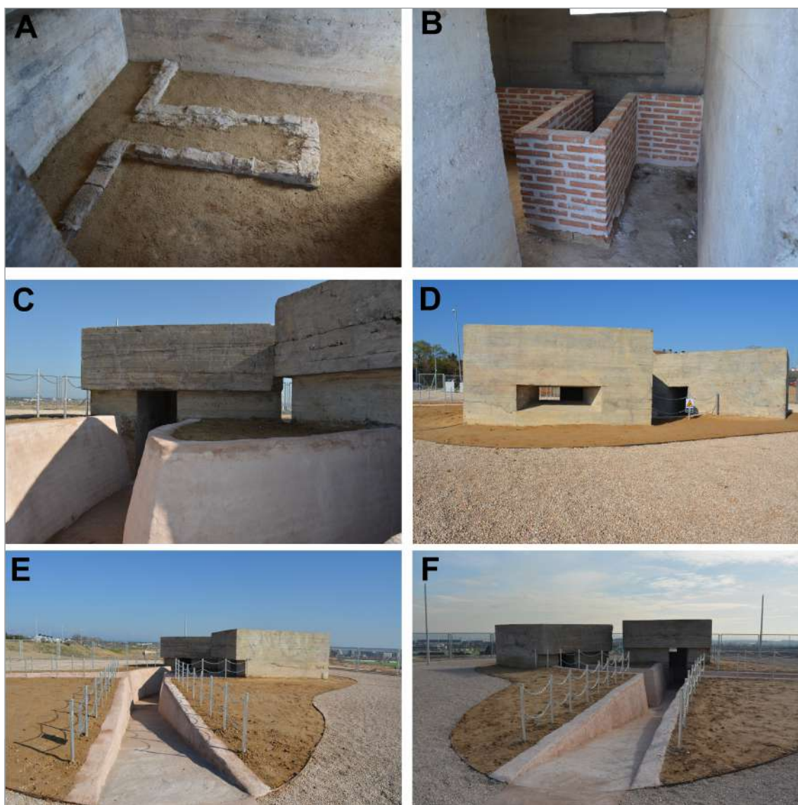
Figura 8. A: colocación de los restos de la banqueta en el fortín nº 1. B: la banqueta recreada con nuevas hiladas de ladrillo hasta su altura original. C, D, E, F: vistas de los fortines y la recreación de las trincheras.
