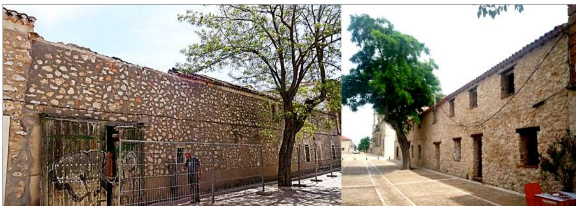
Figura 2. Fachada a la calle del Palacio antes y después de la rehabilitación (Foto F. Vallespín).
