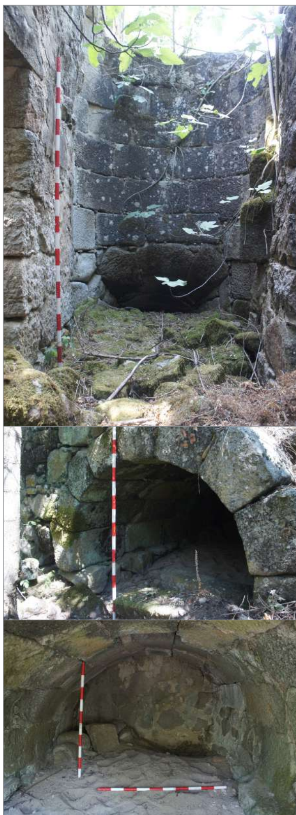
Figura 2.- Restos del cubo amortizado en el pozo de la aceña y del cárcavo del antiguo molino de Juan. (Gómez Osuna, 2018).
