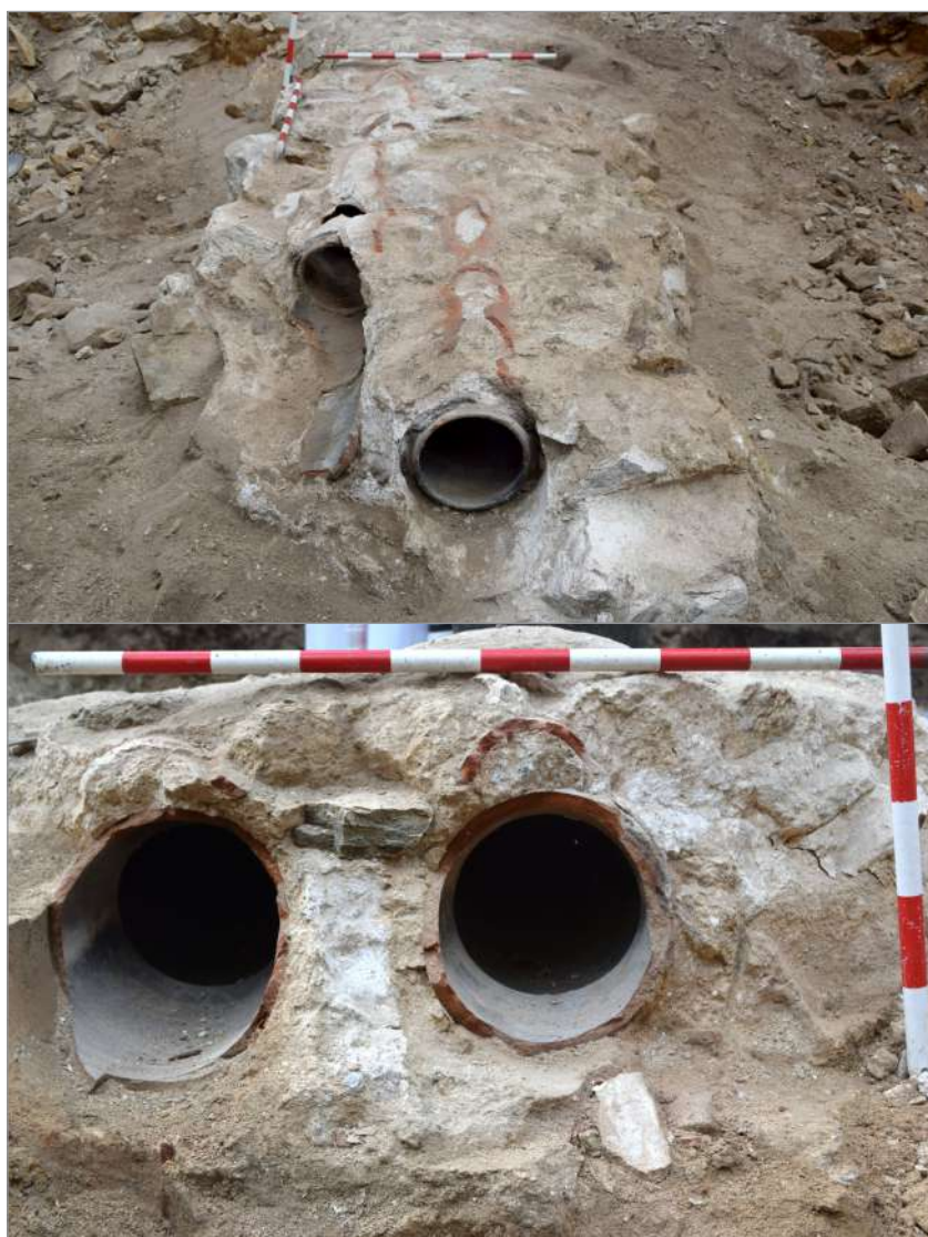
Figura 5. Tubos de entrada de agua al arca de Carlos Ruiz, 4 (izda.) y detalle constructivo en la salida del registro, con la cubierta de teja que protege las tuberías.
