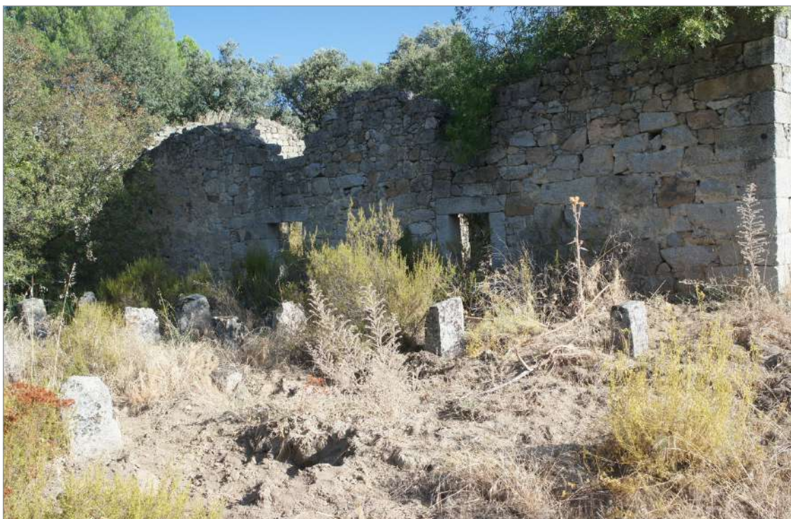
Figura 5.2- Almacén exterior de tableros de mármol. (Gómez Osuna 2018)
