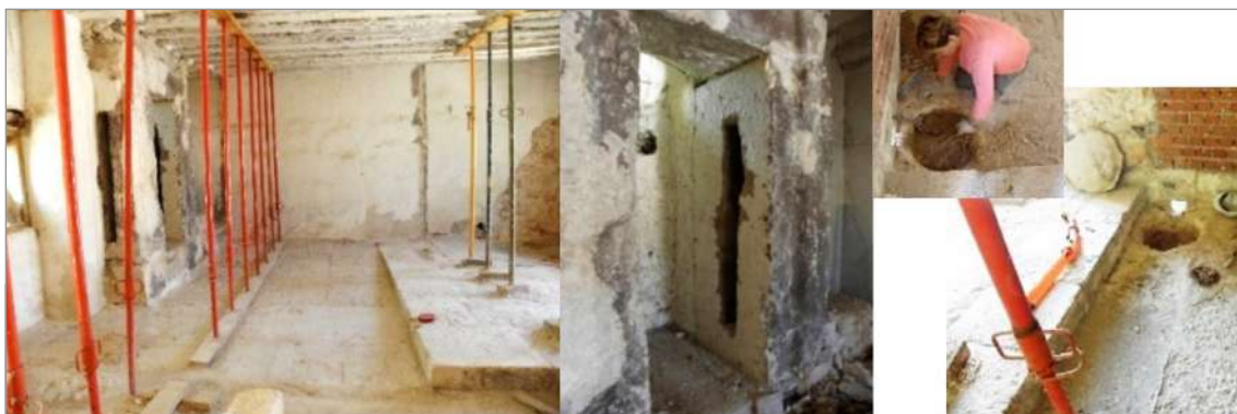
Figura 5: El lagar, las vírgenes monolíticas, gavia, cubeta y boca de salida del mosto (Foto F. Vallespín).
