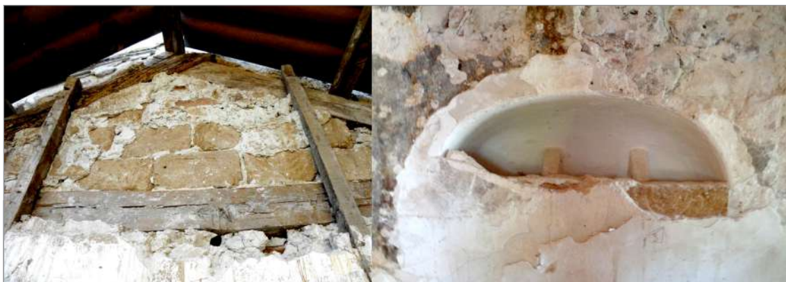
Figura 5. Muro y hornacina de adobe de fundación con incisiones semicirculares (Foto F. Vallespín).
