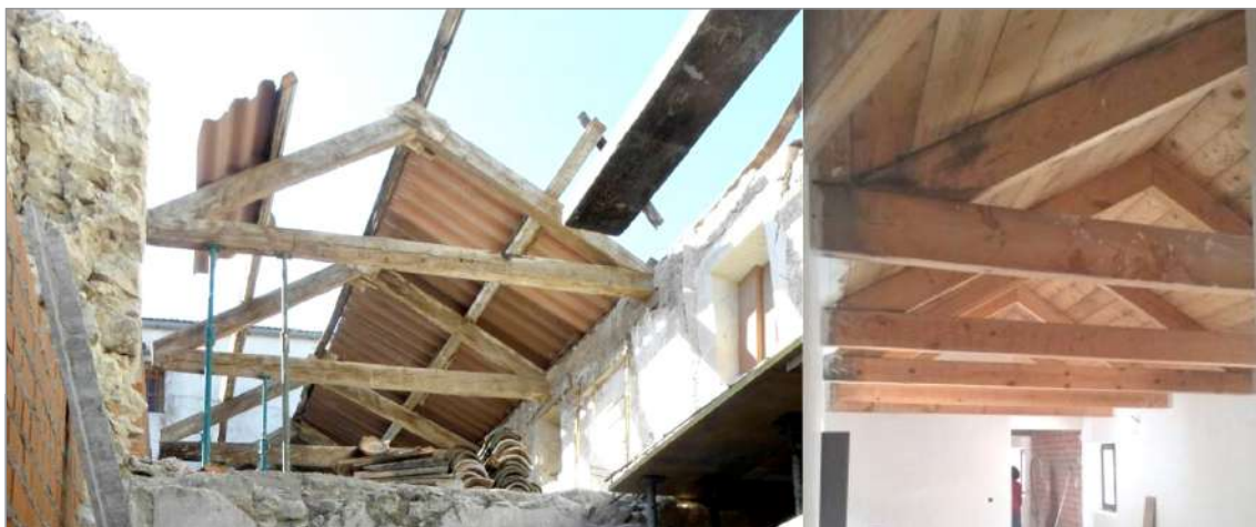
Figura 6. La cubierta del edificio antes y después de la rehabilitación (Foto. F. Vallespín).
