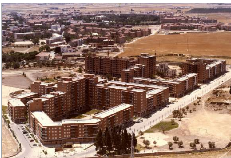
Figura 6. La Urbanización “Parque Eugenia de Montijo” durante su construcción, hacia 1965. Entre los edificios en construcción se aprecian los restos del Palacio, como un ejemplo gráfico de la desaparición del patrimonio histórico carabanchelero y su sustitución por nuevas construcciones (fotografía: Servicio Histórico del COAM).
