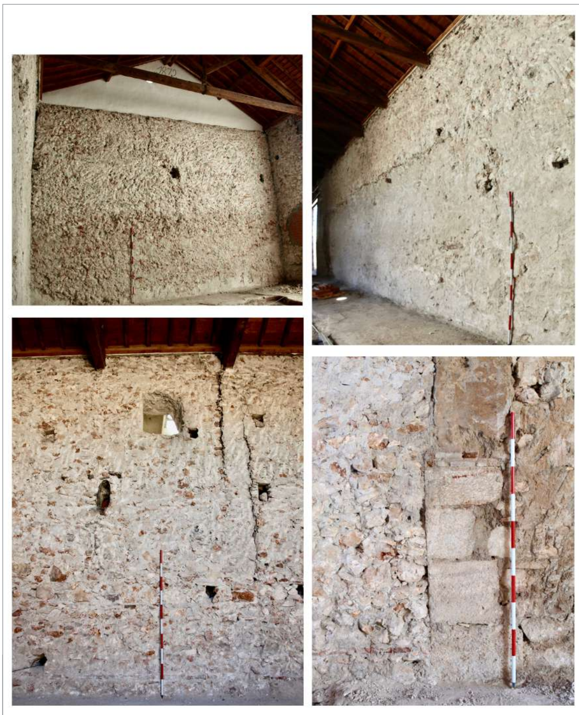
Figura 5. Diversos aspectos de la nave norte.
